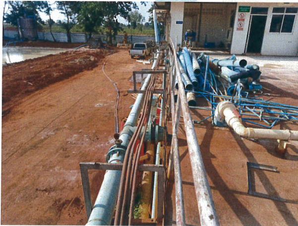
16.1.3 รื้อถอนท่อที่กีดขวางพื้นที่ปากบ่อ
